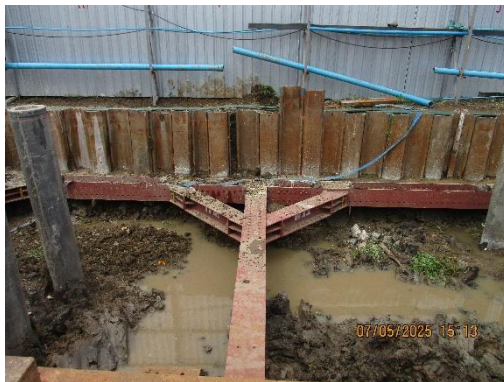
รูปที่ 10 แนว Sheet Pile และทำค้ำยันเหล็ก (Bracing)
